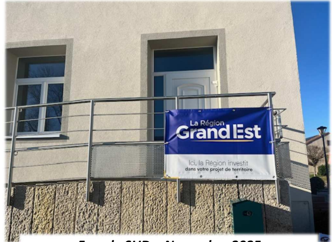
Façade SUD – Novembre 2025
