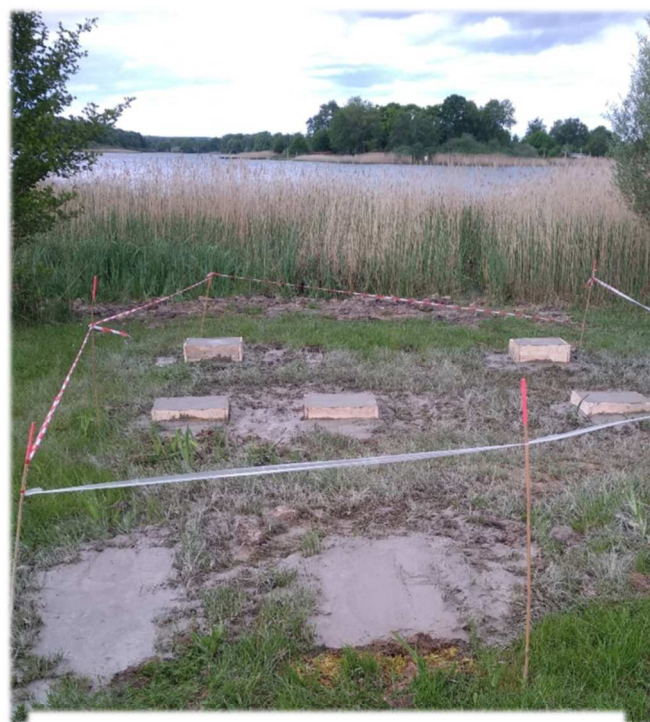
Préparation des plots en béton pour supporter la structure de l'observatoire
