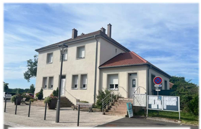
Fin des travaux – Juillet 2025
