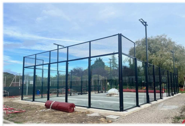
Pose de la structure
