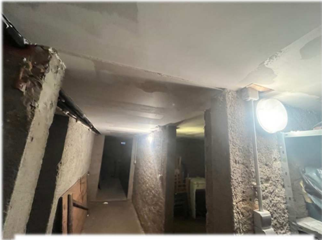
Isolation sous-sol et pose de placo plâtre – Cave Mairie
