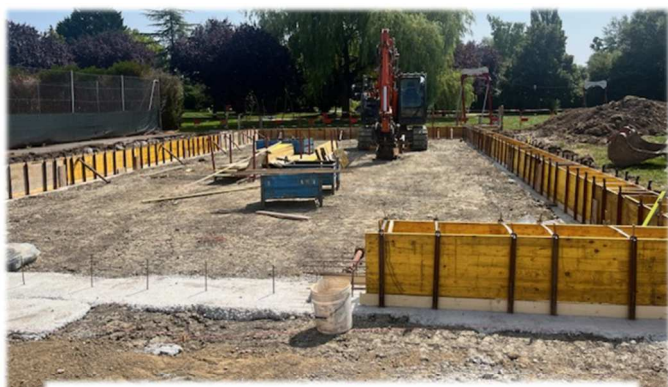
Démarrage des travaux avec la création de la dalle – Début Septembre 2025
