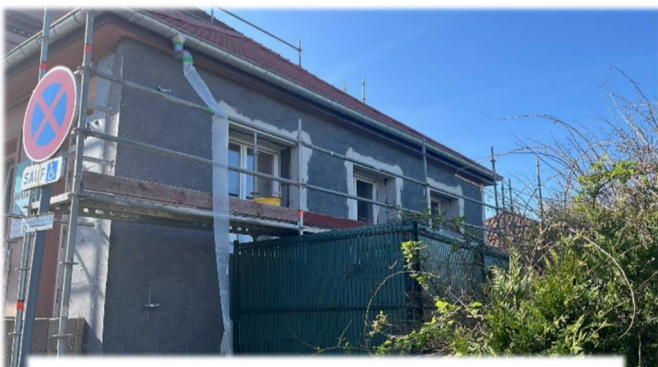
Début des travaux sur la façade – Mars 2025
