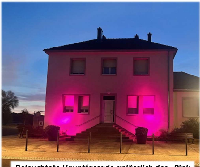
Beleuchtete Hauptfassade anlässlich des „Pink October“ – Oktober 2025
