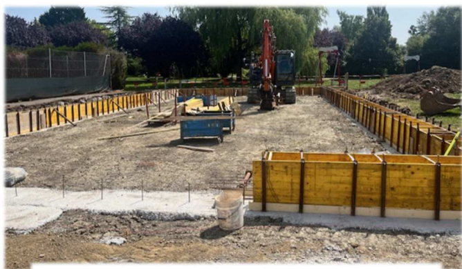
Beginn der Arbeiten mit der Erstellung der Bodenplatte – Anfang September 2025
