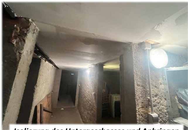
Isolierung des Untergeschosses und Anbringen von Gipskartonplatten – Keller des Rathauses
