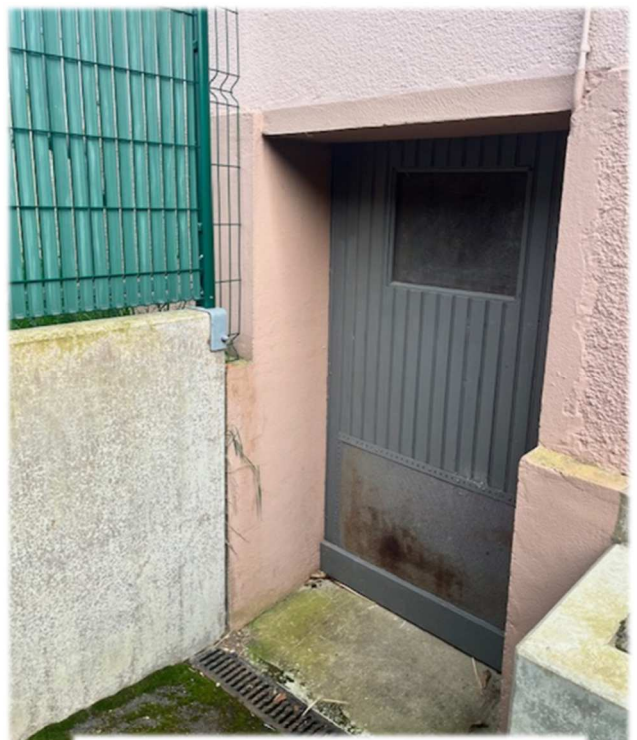
Ehemalige Kellertür, Zugang von außen – Mai 2025
