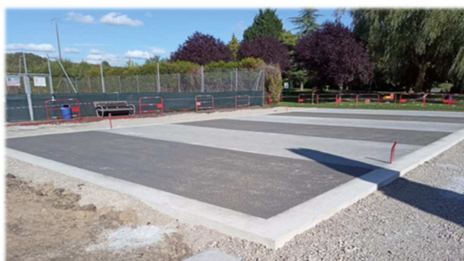
Beginn der Arbeiten mit der Erstellung der Bodenplatte – Anfang September 2025
