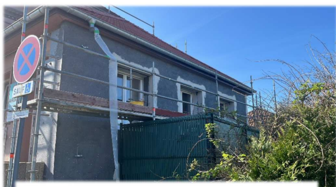
Beginn der Arbeiten an der Fassade – März 2025
