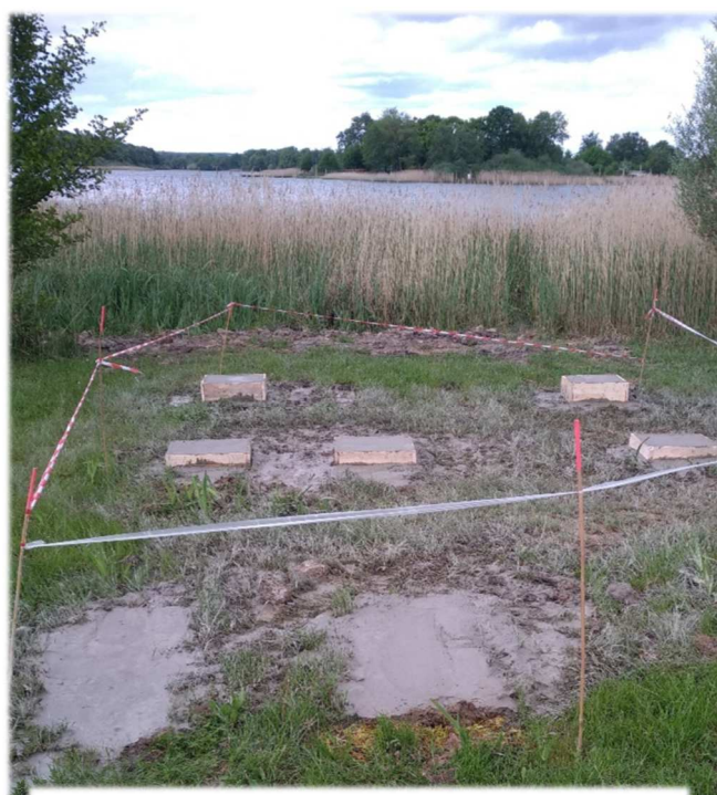
Vorbereitung der Betonfundamente zur Abstützung der Observatoriumskonstruktion
