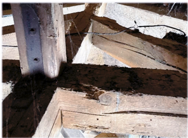
Photo des poutres de la charpente avant travaux
