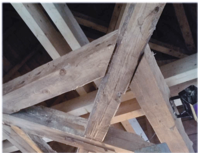
Photo après traitement et renforcement des poutres
