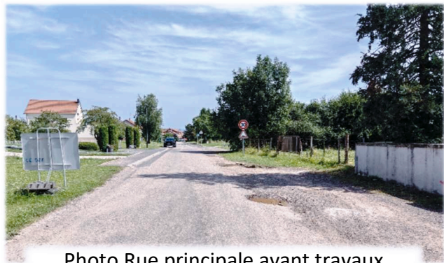
Photo Rue principale avant travaux
