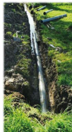
Zu Beginn des Jahres wurde Weibel Création mit Arbeiten beauftragt, um überschüssiges Regenwasser auf der Höhe Hauptstrasse ableiten zu können. Man verlegte ein neues, größeres Rohr, um so den Abfluss des Wassers zum See hin zu gewährleisten.
