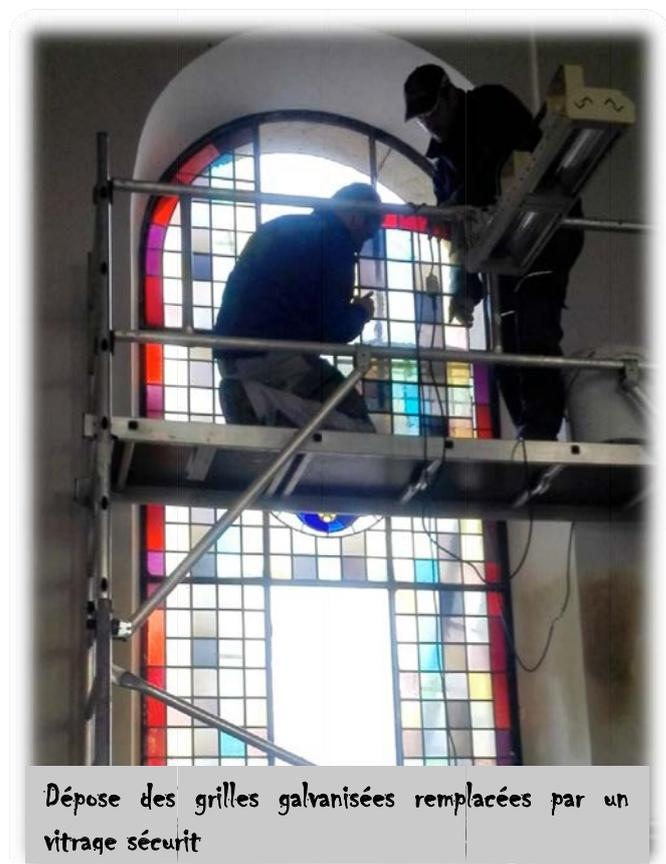
Dépose des grilles galvanisées remplacées par un vitrage sécurisé
